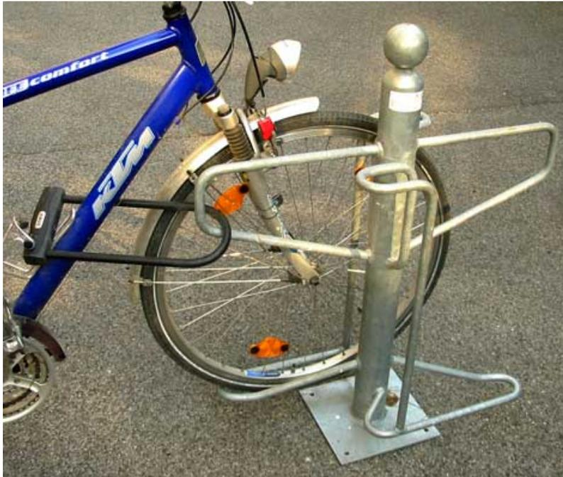
Die Befestigung ist etwas gewöhnungsbedürftig. Man erwartet, dass sowohl der Rahmen als auch das Vorderrad befestigt werden können. Dies ist uns mit einem Bügelschloss allerdings nicht gelungen, sondern es konnte nur der Rahmen befestigt werden. In der Praxis ist aber eine Befestigung des Vorderrades nicht unbedingt notwendig, weil bei angehängtem Fahrrad das Abmontieren des Vorderrades fast unmöglich ist.
