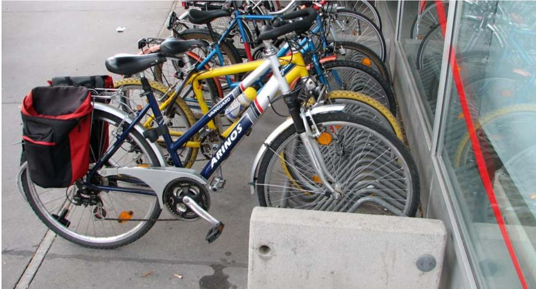
Der Ständer ist aber von der Funktion her eine normale Felgenklemme und genau so schlecht. Das Fahrrad wird nur durch einen Teil der Vorderradfelge fixiert, mit der Gefahr, dass die Felge leicht verbogen werden kann. Eine Befestigung des Fahrradrahmens ist auch unmöglich. Der Preis von etwa 100 Euro je Fahrradabstellplatz platziert den Ständer hoch oben auf der Preisskala. Um dasselbe Geld können hochwertige Radständer angeschafft werden.
