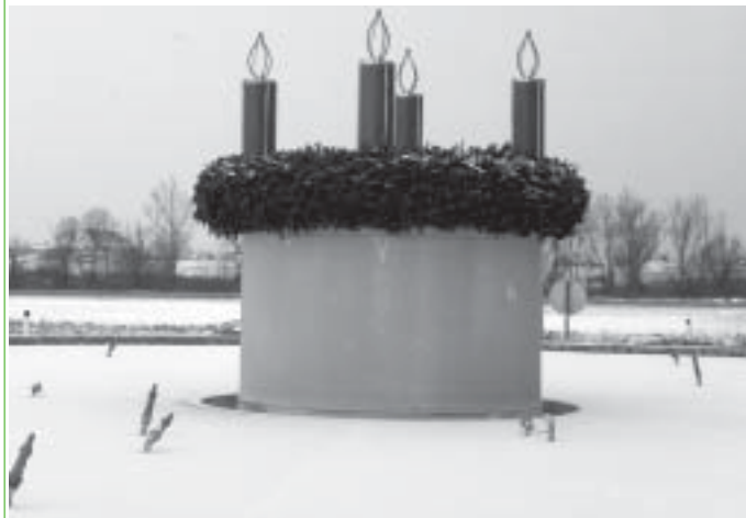
Die behübschte „Installationsbaustelle“ - Brunnen im Kreisverkehr...
